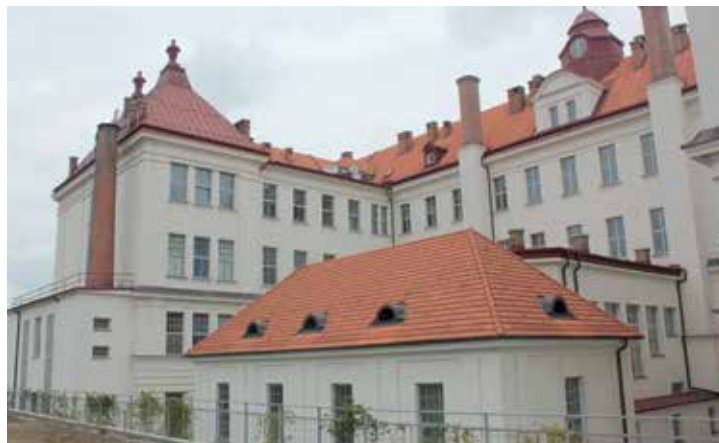
Prostory bývalé sladovny a pivovaru na dnešní VUT v Brně na dnešní Žižkově ulici jsou částečně prázdné a částečně využívané pro účely laboratoře vodního hospodářství (na snímku).
